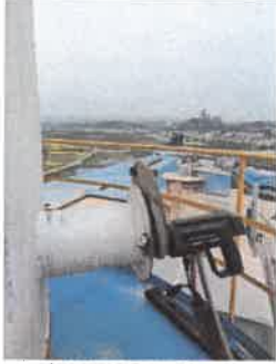
◎1 压机成型废气排口 DA001
