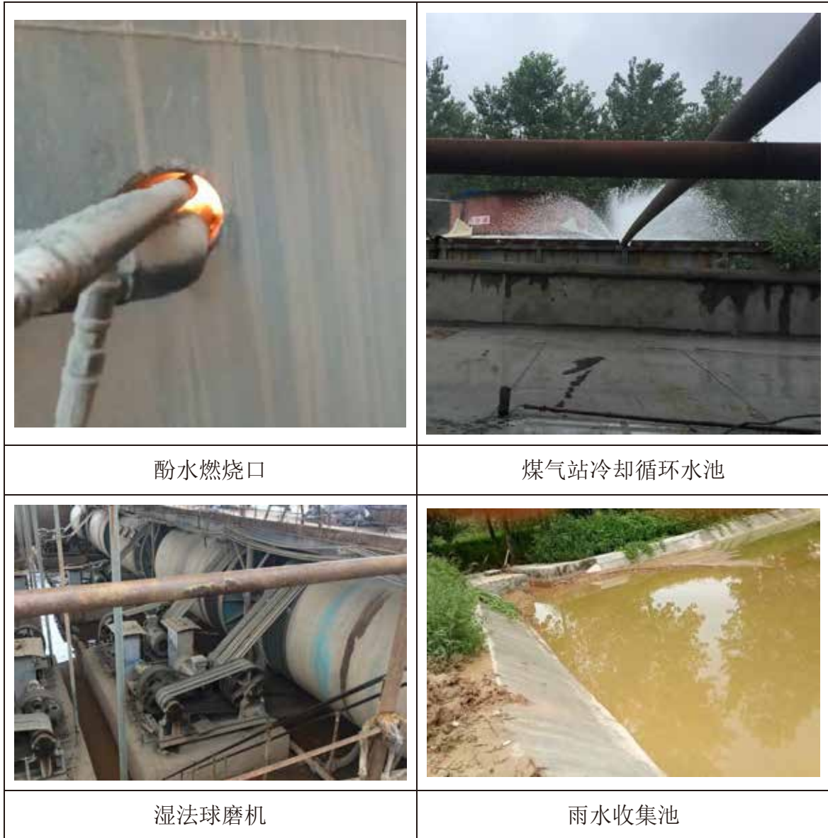
图 2.2-2 废水处理设施现场照片
